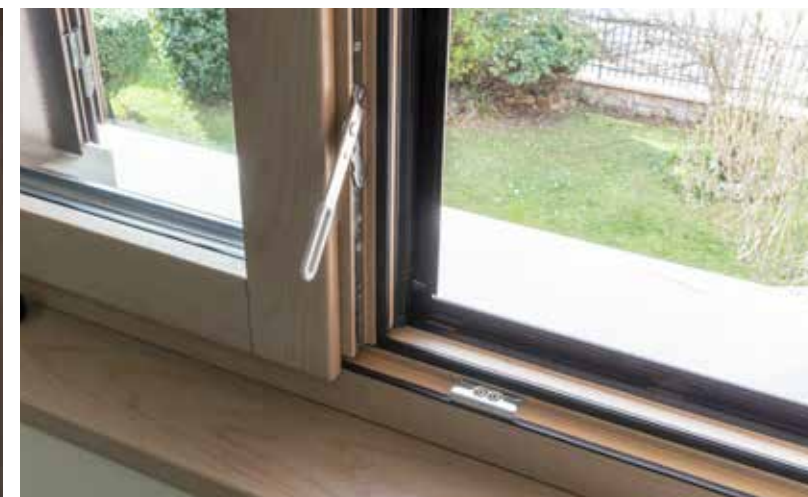
Nodo inferiore finestra con asta a leva
